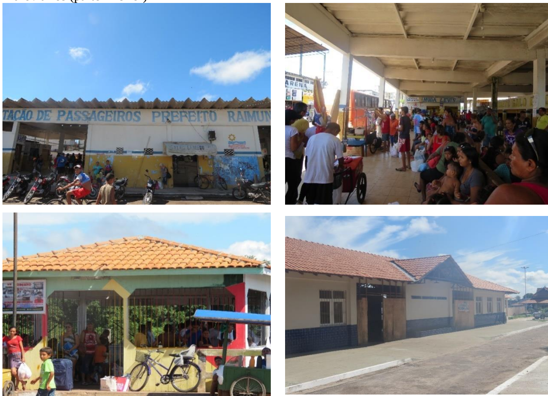
Fotografia 6 - Terminal rodoviário Intermunicipal e Intramunicipal (parte superior) e terminais hidroviários (parte inferior)
