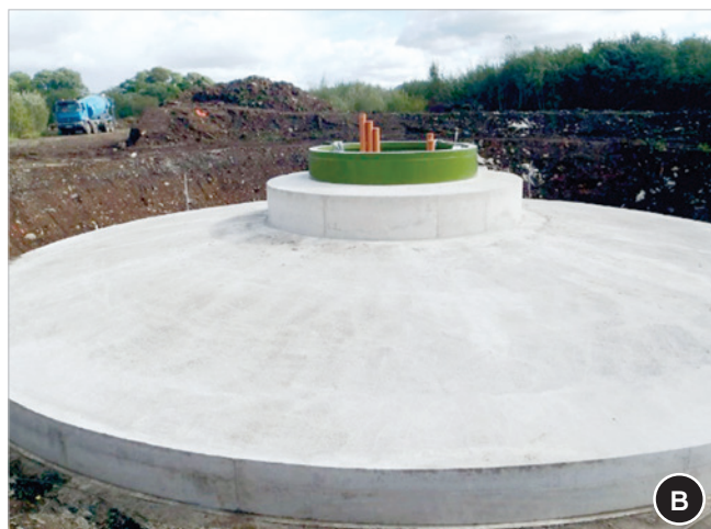
Figura 1 Exemplos do uso de sapatas como fundação em grandes estruturas
