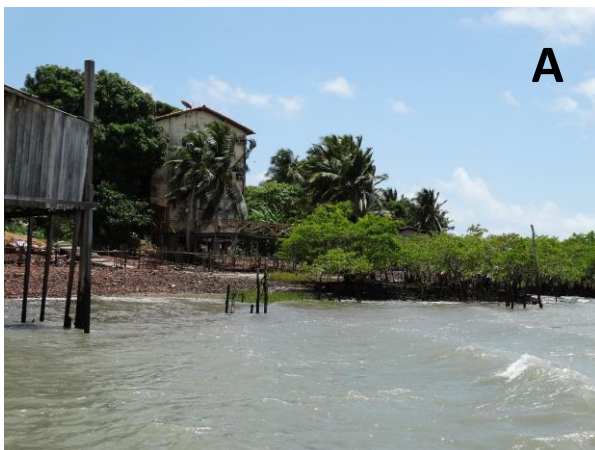
Figura 54- (A) Região com ausência de obras de contenção diariamente inundada protegida da ação erosiva pela vegetação de mangue. (B) Setor sem obra de contenção e vegetação totalmente exposto aos agentes costeiros, na orla marítima de Marudá, em 2017.
