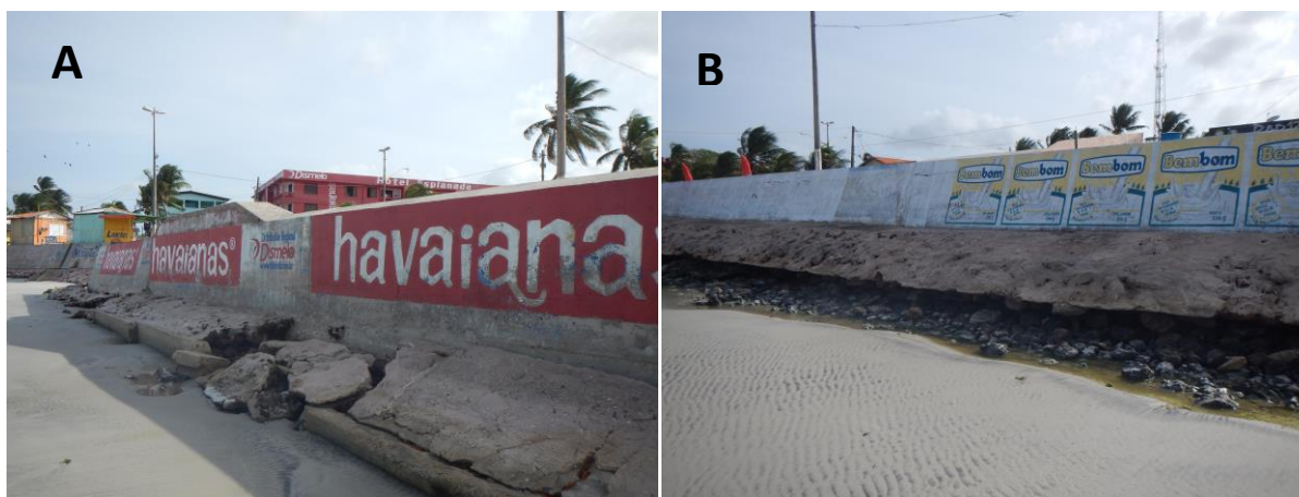
Figura 30- (A) Indícios do intenso processo erosivo, destruição de cordão de enrocamento na orla de Marudá em 2017. (B) Descalçamento de cordão através da remobilização de material, na orla de Marudá em 2017.
